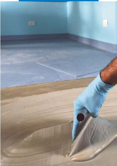
Aanbrengen van Ultrabond Eco 380
