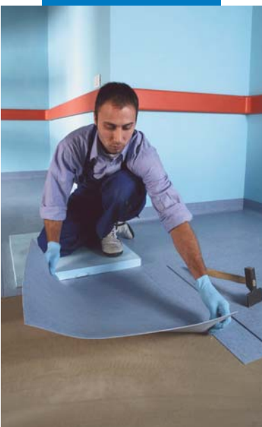
Aanbrengen van de vloerbekleding van pvc als tegels
